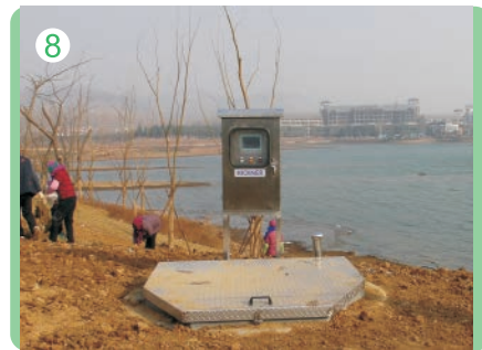
8 安装完成 Completion of installation
